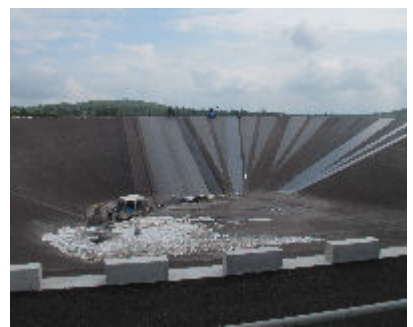
京極揚水発電所 上部調整池
